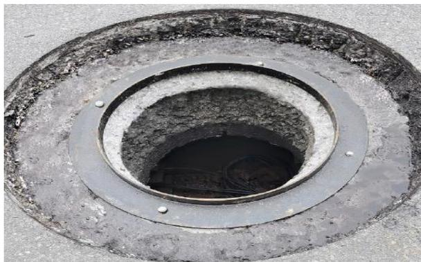
5、分层回填，中、下面层采用中粒式沥青混合料分层回填并夯实；
