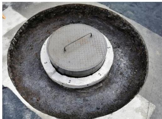
5、中、下面层采用中粒式沥青混合料分层回填，气夯夯实6遍。
