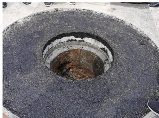
7、安装井盖，拉线调整井盖高度，比上面层高5-10mm。
