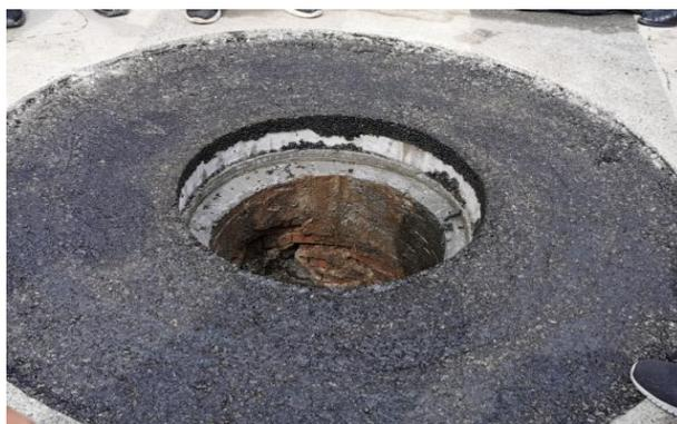
6、使用起重机将新井盖安装到井口上并进行固定，确保新井盖与道路平齐，无晃动和异响；
