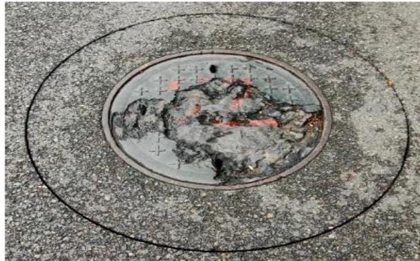
3、利用风镐将沥青破碎并清理，同时对旧井盖或井座进行拆除，注意避免对周围道路产生破坏；
