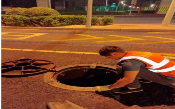
4、将新胶垫圈嵌入凹槽内，胶垫圈安装应高出井座支承面
