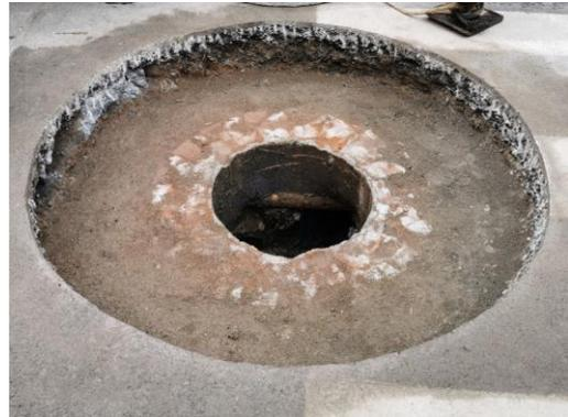
3、拉十字线，座浆安装预制调节环，高度与下面层齐平；
