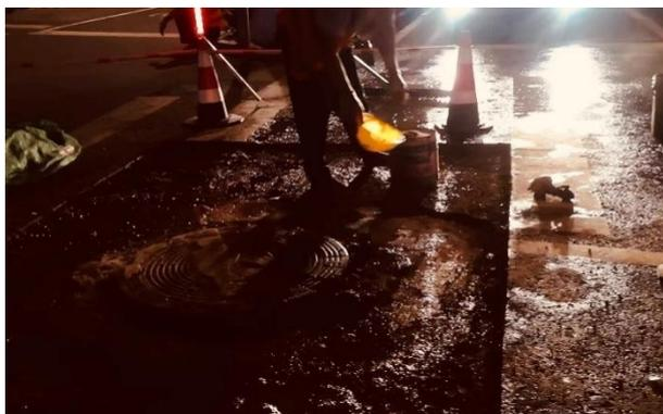
6、压实，使用压路机对回填进行压实，确保回填与周围路面结合紧密。
