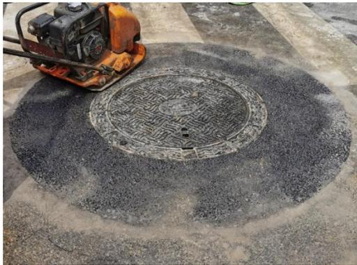
10、清理周围路面，根据需要，采用小围挡围护自然降温或洒水降温至常温后开放交通。
