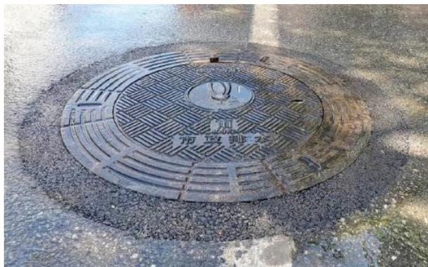
4、更换完成后应启闭，确认检查井盖能否正常开启。
