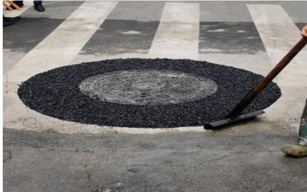
8、夯实路面，使用压实机具将沥青夯实。
