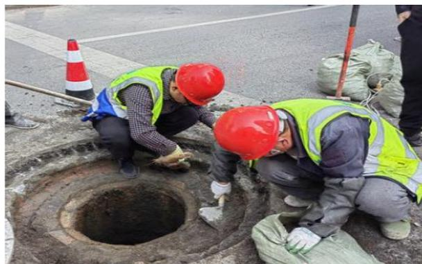
4、安装调节环，调节环应安装在混凝土井圈顶面，安装必须平整、稳固；且调节环的中心与切圆中心一致。
