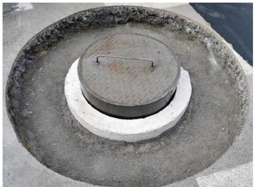
4、标记回填分层线，每层压实厚度 5-7cm；井周喷洒粘层沥青。
