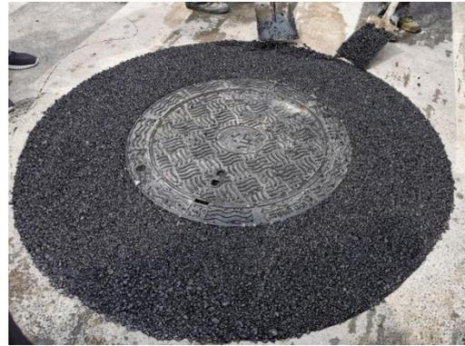
9、双钢轮压路机骑井盖静压一遍，振动碾压 2 遍，水平尺检查平整度，最后采用新型压实机具细部处理。
